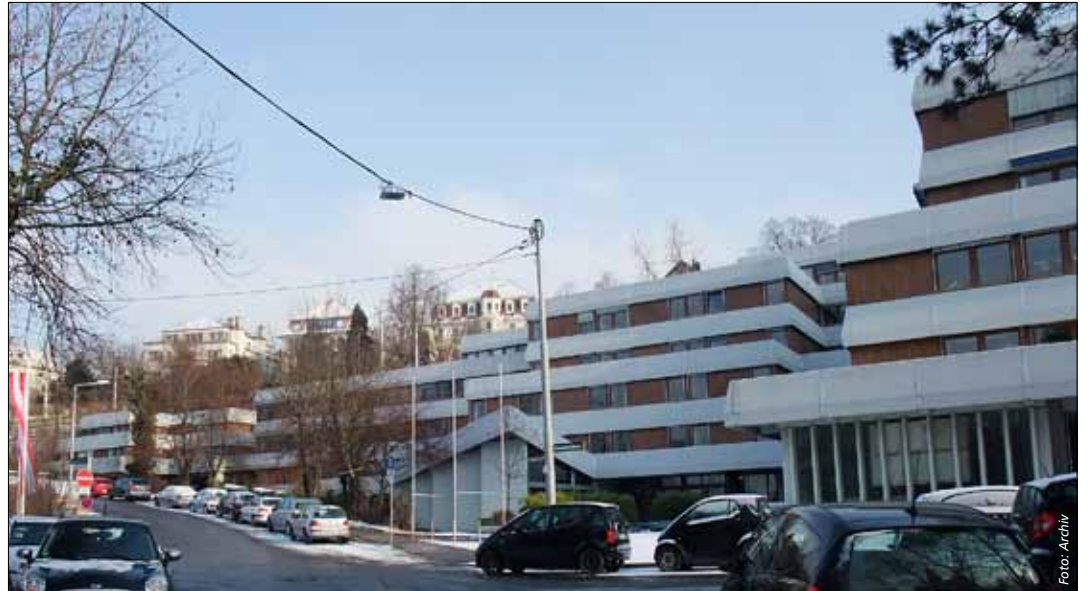
Das Bürogebäude wird wohl abgerissen und durch Wohnhäuser ersetzt
