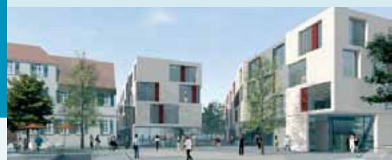
ehemalige Lederfabrik Christ. Breuninger, Schorndorf Gaus & Knödler, Architekten und h4a Gessert + Randecker Generalplaner GmbH
